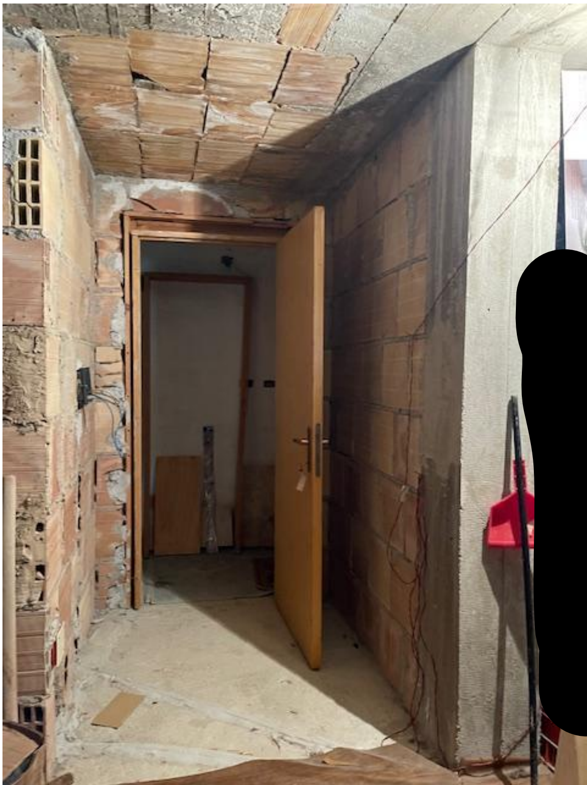
vista dell'ingresso al locale sottotetto
